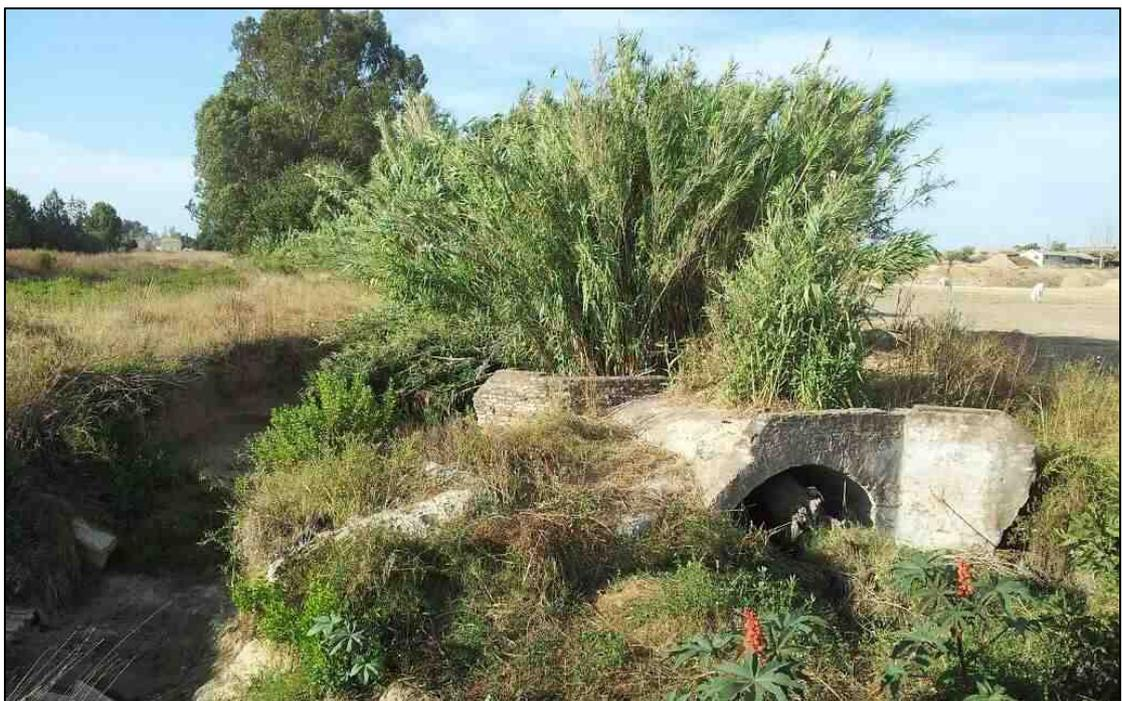
A escasos diez metros aguas abajo del puente derruido se encontrará el punto donde se prevé realizar la evacuación de pluviales del Sector Z2 (unidad de ejecución 1) de Bormujos. Para acometer este punto de evacuación se dispondrá un refuerzo a los taludes de ambas márgenes y al lecho del arroyo. En el próximo apartado de Actuaciones sobre el encauzamiento se describirá con detalle.
