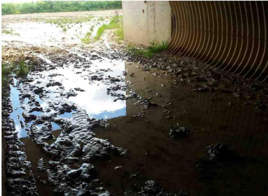
Junto con el hecho de que el paso de agua bajo la autovía es insuficiente, se da la circunstancia que está ejecutado muy elevado sobre el lecho del canal, lo cual impide su correcto funcionamiento, así como la imposibilidad de que entre totalmente en carga sin que previamente se haya desbordado el cauce natural y genere una significativa lámina de inundación.
