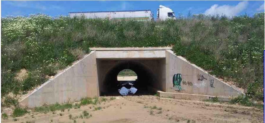
Este paso, con un premarco de hormigón, tiene una altura libre de paso de 3,6 m y una anchura de 6 metros. En la siguiente fotografía se muestra la proximidad de ambos puntos, escasos 25m.
