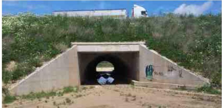
Este paso, con un premarco de hormigón, tiene una altura libre de paso de 3,6 m y una anchura de 6 metros.
