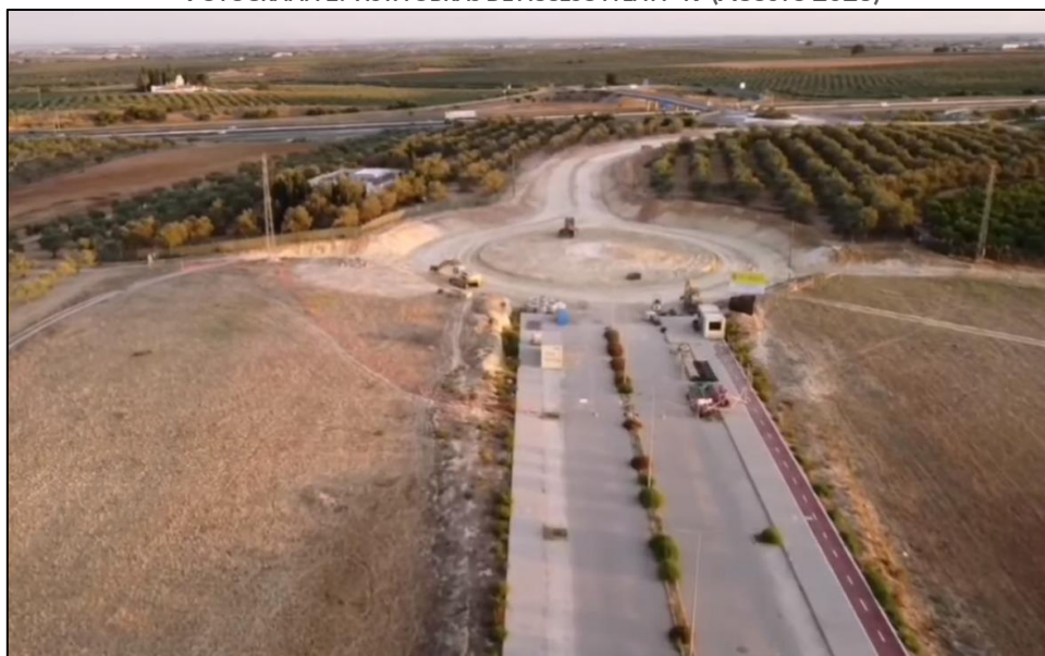
FOTOGRAFÍA 1. VISTA OBRAS DE ACCESO A LA A-49 (AGOSTO 2023)
