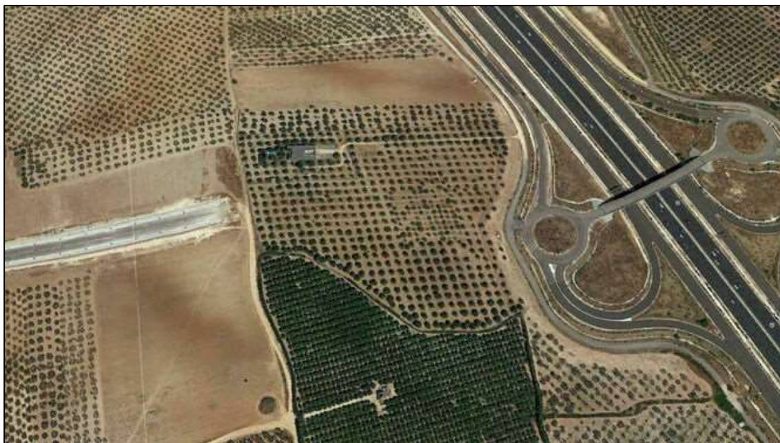
FOTOGRAFÍA 1. ORTOFOTO DE SITUACIÓN DEL RAMAL DE CONEXIÓN DE ESPARTINAS CON A-49.
