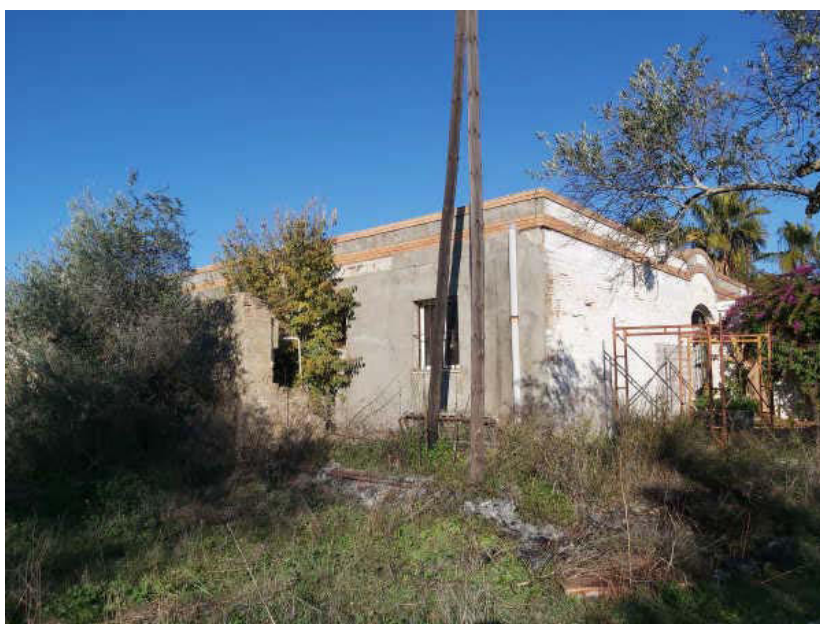
Chalet en obras. Fachadas
