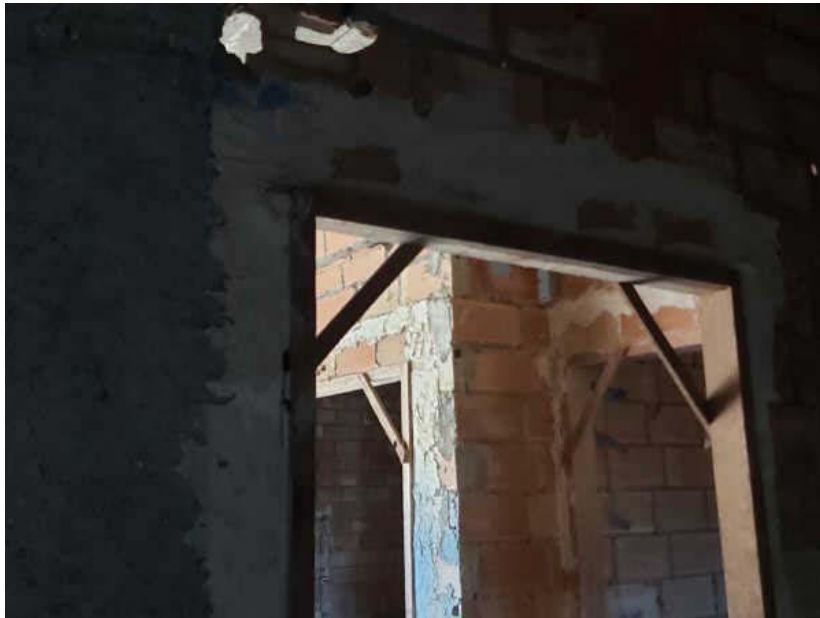
Chalet en obras. Interior
