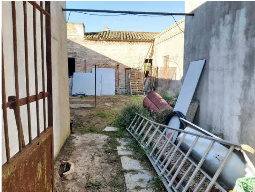
Chalet en obras. Fachadas
