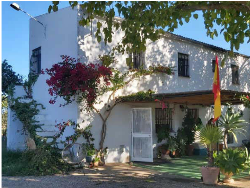
Chalet terminado. Fachadas
