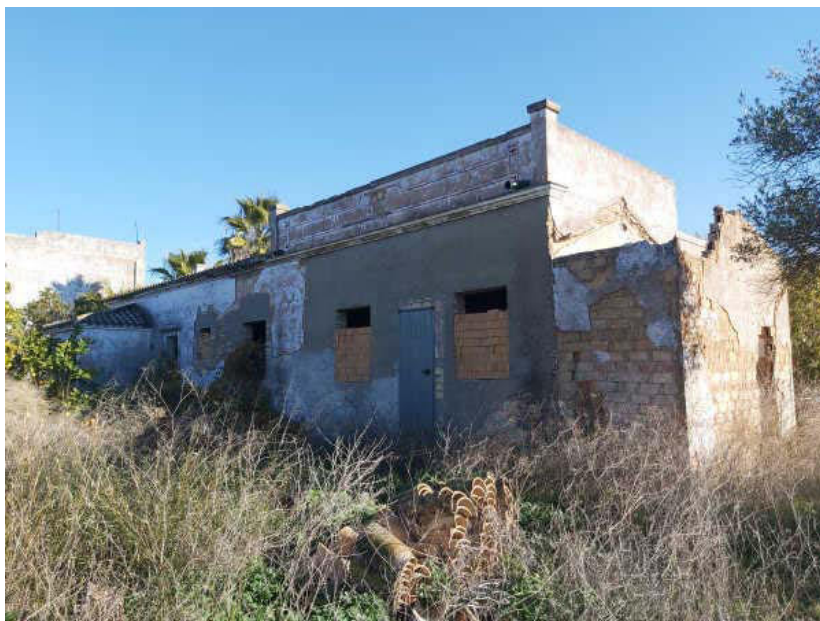
Chalet en obras. Fachadas
