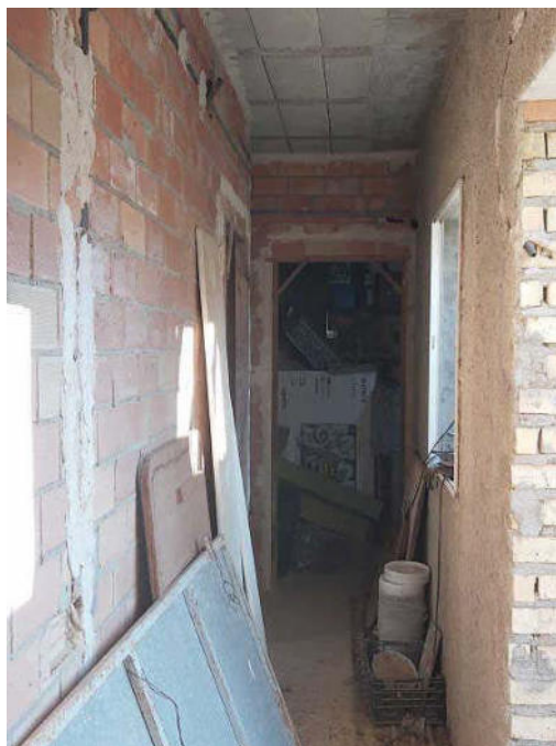
Chalet en obras. Interior
