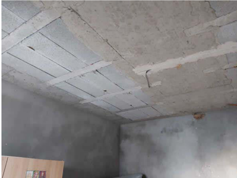
Chalet en obras. Interior
