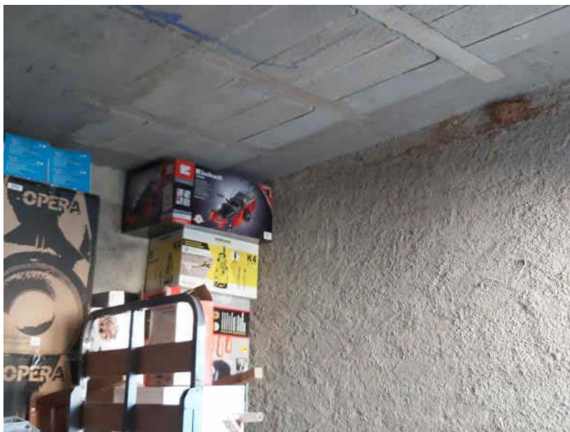
Chalet en obras. Interior
