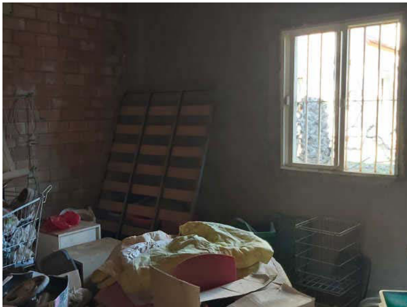
Chalet en obras. Interior
