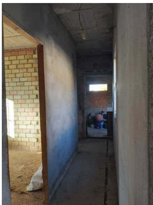
Chalet en obras. Interior
