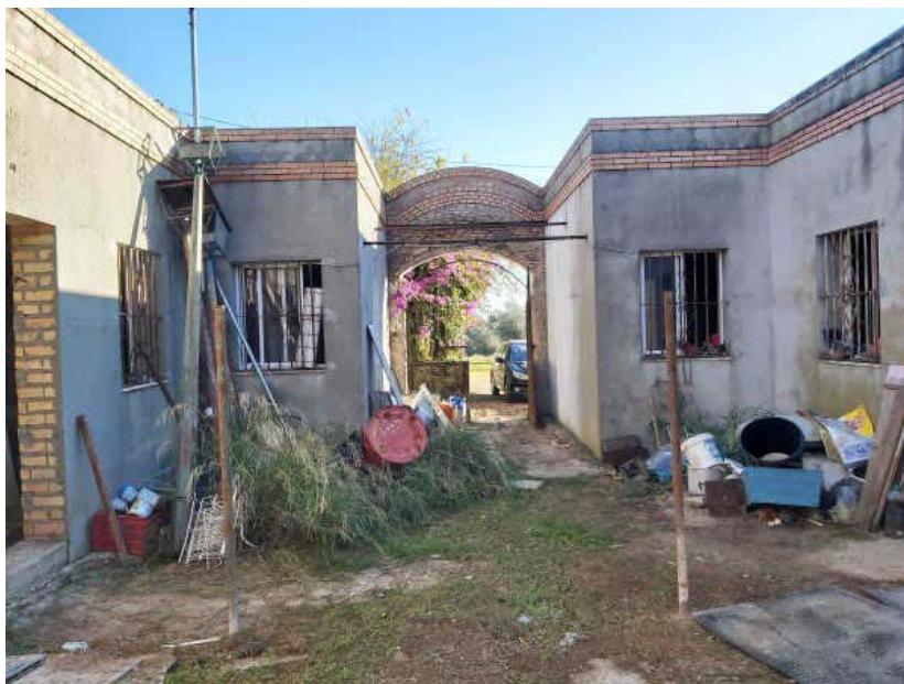
Chalet en obras. Fachadas
