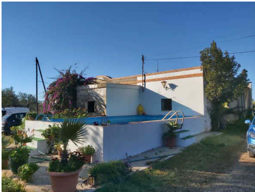
Chalet en obras. Fachadas
