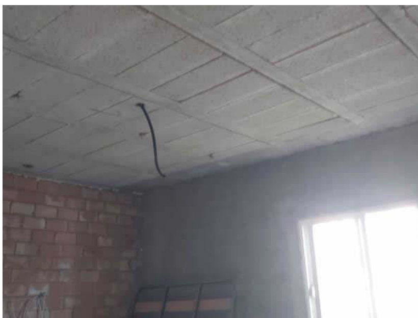
Chalet en obras. Interior
