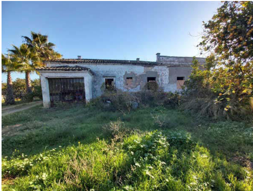
Chalet en obras. Fachadas
