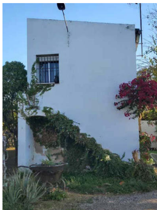
Chalet terminado. Fachadas
