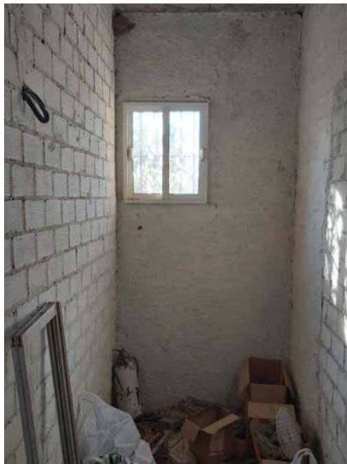
Chalet en obras. Interior
