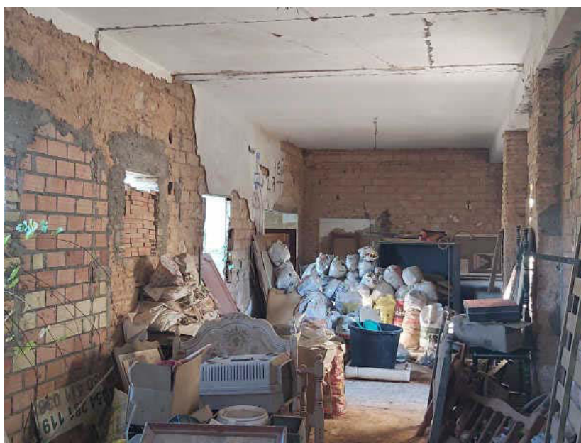
Chalet en obras. Interior
