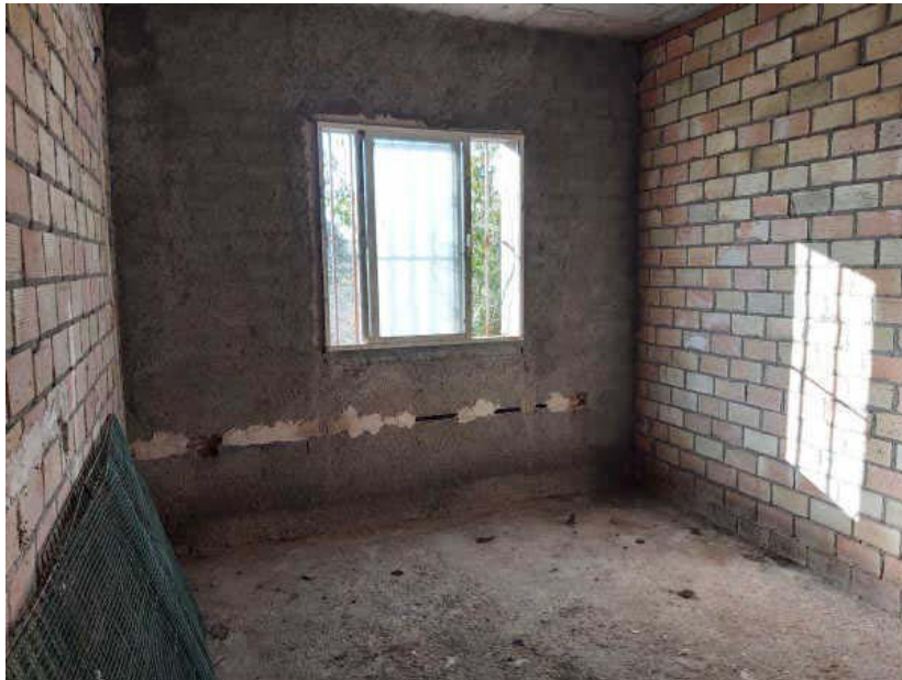
Chalet en obras. Interior
