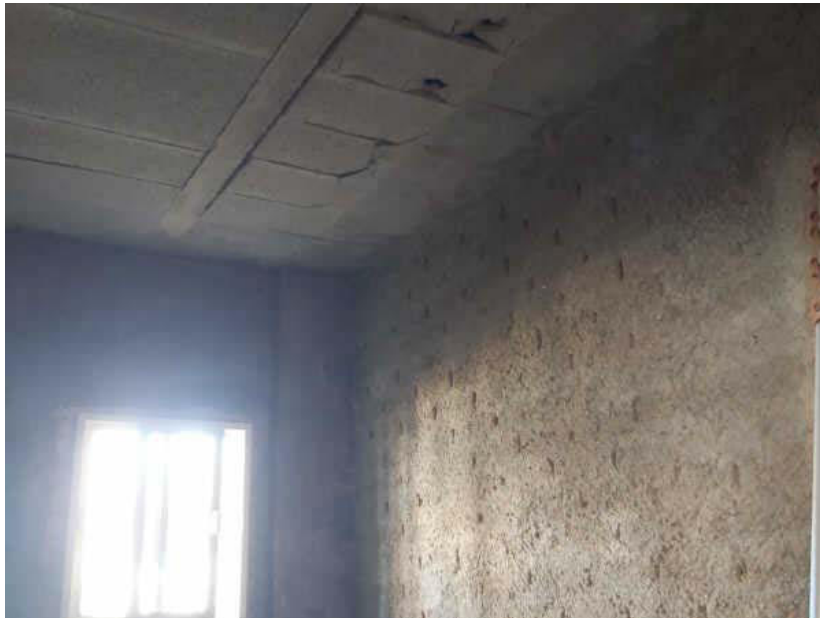
Chalet en obras. Interior
