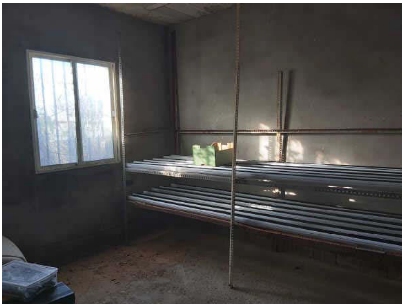
Chalet en obras. Interior
