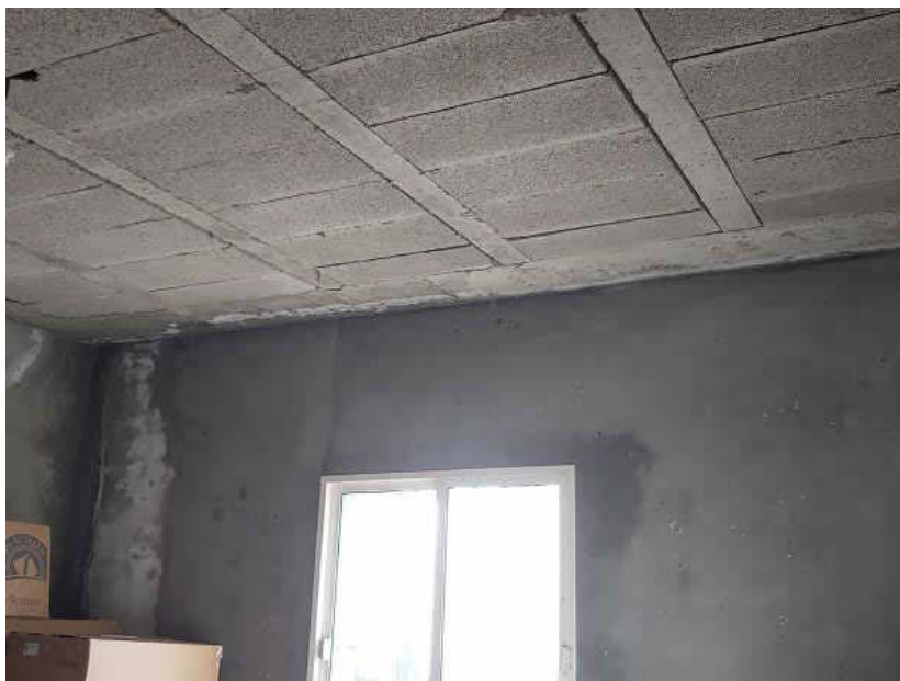
Chalet en obras. Interior
