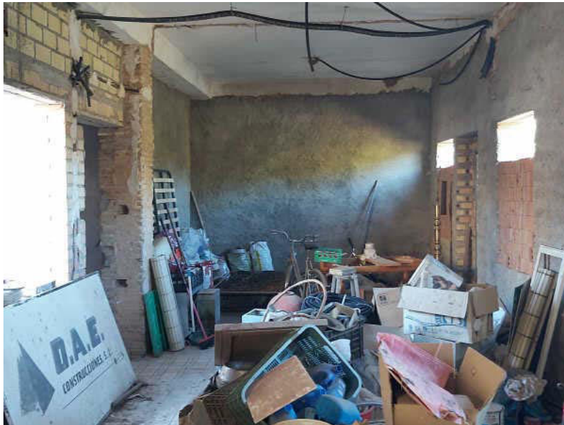
Chalet en obras. Interior
