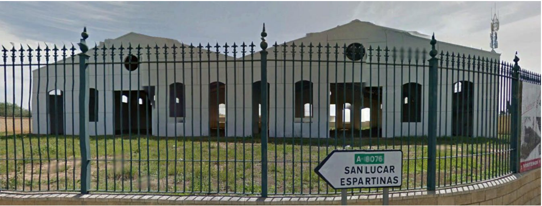
Figura nº 11. Vista primitiva de la fachada principal de las naves objeto del documento.
