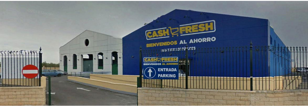
Figura nº 12. Vista previa de la fachada principal de las naves objeto del documento.
