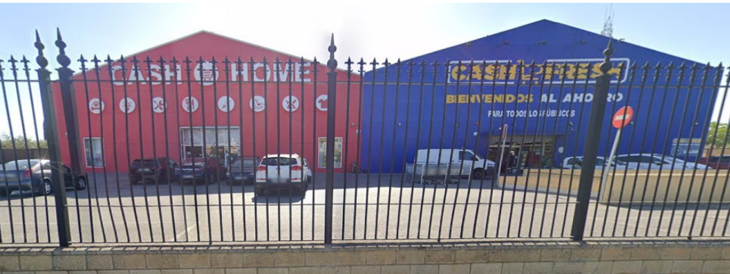
Figura nº 13. Vista actual de la fachada principal de las naves objeto del documento.
