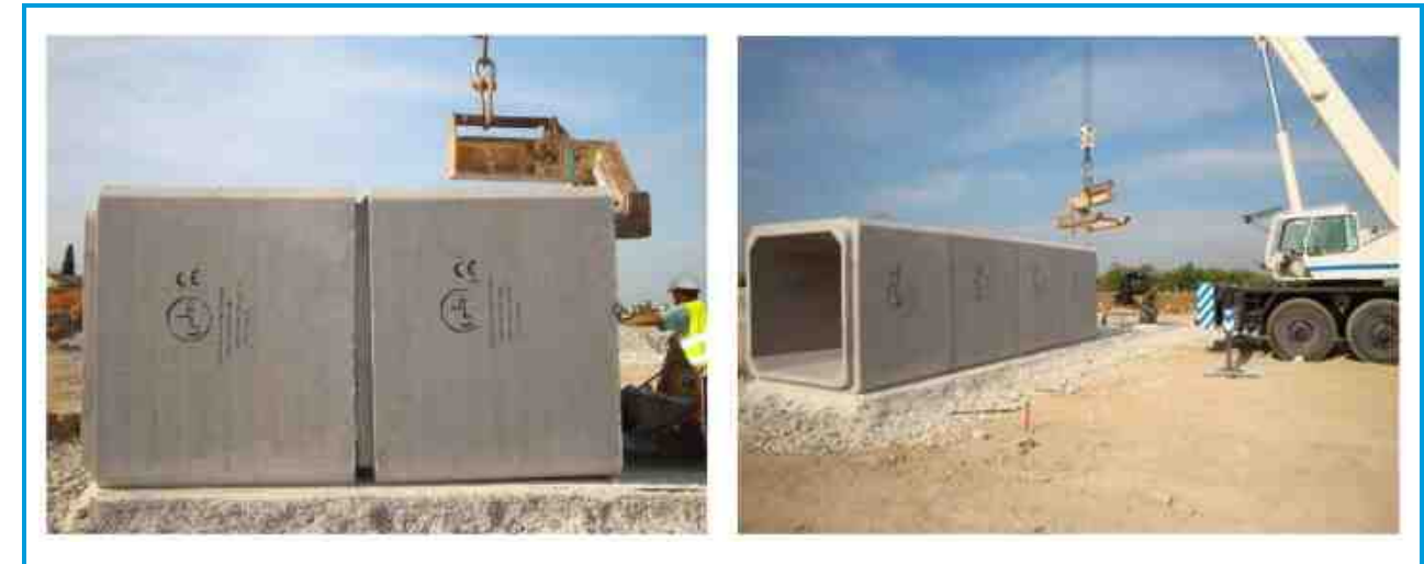
Imagen 11 – Colocación de marcos unicelulares.
