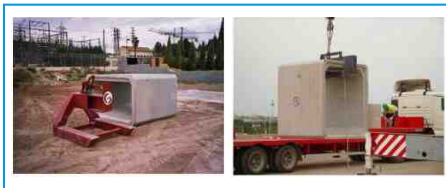
Imagen 8 – Descarga de marcos mediante pinza homologada.
